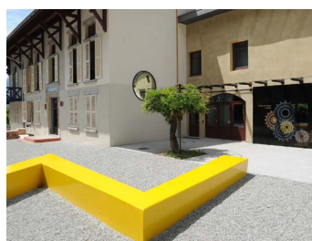
MAISON BERGÈS VILLARD-BONNOT
